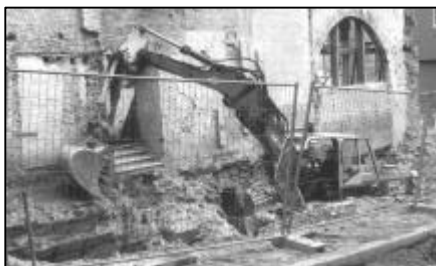
La démolition des caves !
